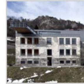
La facciata dello Spazio di Casso, cantiere di A call for a wall_Foto Giacomo De Donà
