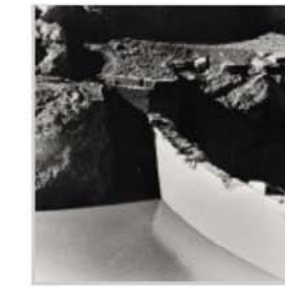
La Diga del Vajont, il coronamento dopo la catastrofe del 1963
